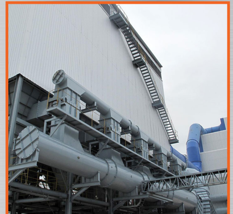
เครื่องดักฝุ่น Dust Collector
